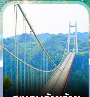
สะพานอ้ายจ้าย
